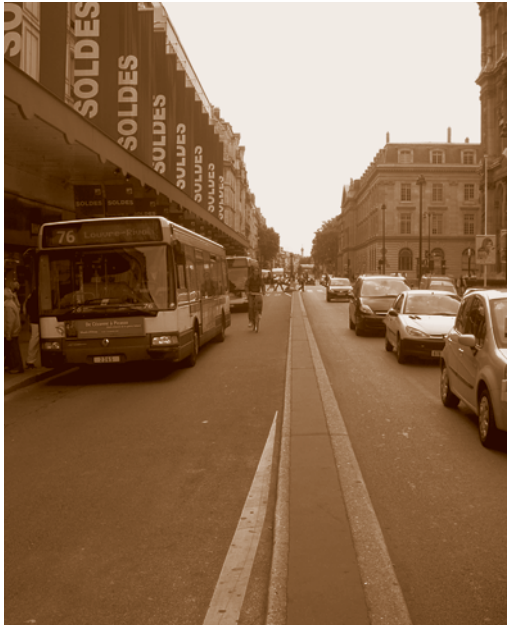
FIG. 1. Vista del carril bus de 4,5 metros de ancho en posición lateral y la integración de los ciclistas en él
